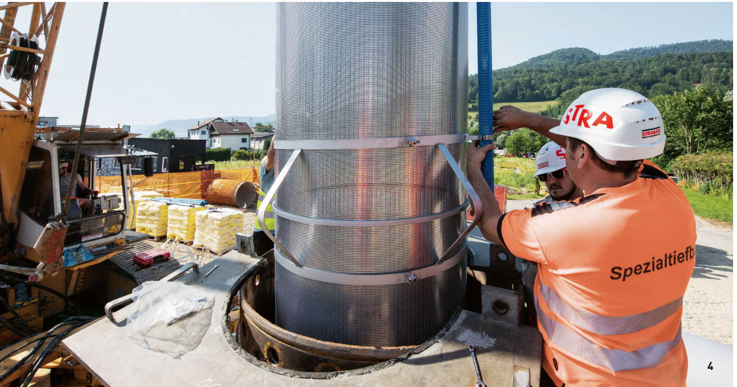
4 Installation d'un puits en acier inoxydable, GWPW Leim, Thürnen BL / 5 Réalisation d'un puits d'eau potable au moyen de forage au grappin, GWPW Chlosterlinde, Diessenhofen TG / 6 Essai de pompage de longue durée à 10'000 l/min, GWPW Aarefeld, Gretzenbach SO
