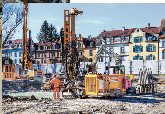
1 Ancrages, nouvelle construction Birkenhaldenstrasse 1, Kilchberg ZH/ 2 Travaux spéciaux EP Schänzli, élargissement Tunnel de Hagnau, Muttentz BL (1 ère fois en Suisse: ancrage Multibond)/ 3 Micro-pieux, Vincentius Areal, nouvelle construction Laubenhof, Constance (DE)
