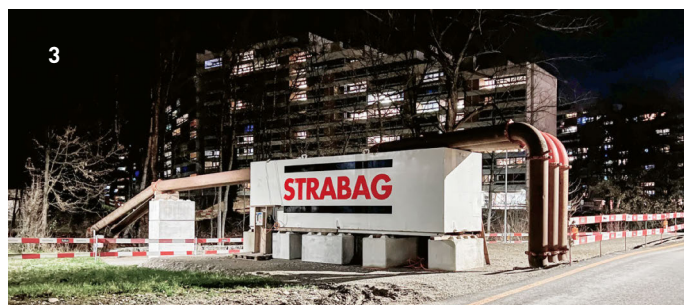
1 Traversée de route pour abaissement de la nappe phréatique, PU ZAS, Zurich-Altstetten / 2 Travaux Wellpoint, MFH Seestrasse, Küsnacht ZH / 3 Installation de traitement des eaux pour abaissement de la nappe phréatique, bâtiment de la police, Aarau AG
